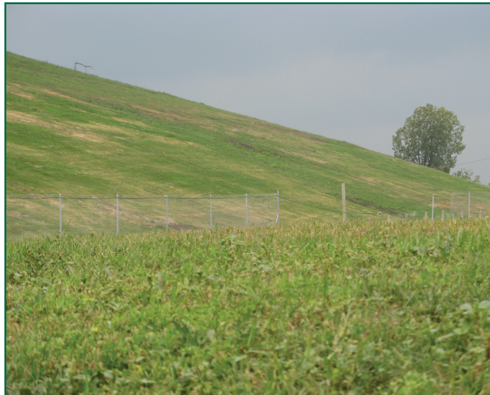
East slope showing final landscaping L'aménagement paysager est terminé sur la pente Est
